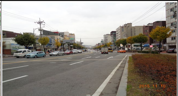
포장부 종점부 전경
