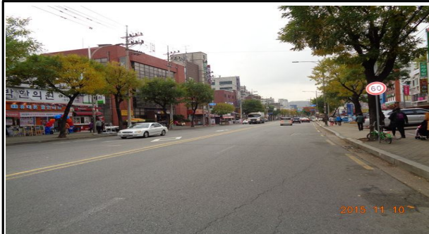
포장부 시점부 전경
